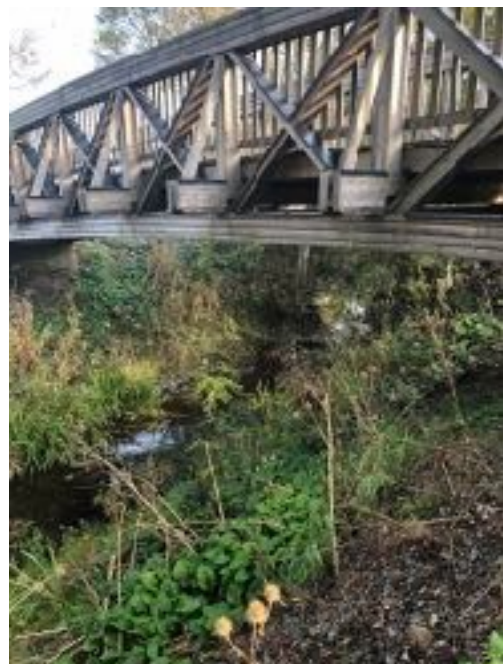
Cykel och gångbro över Braån.
