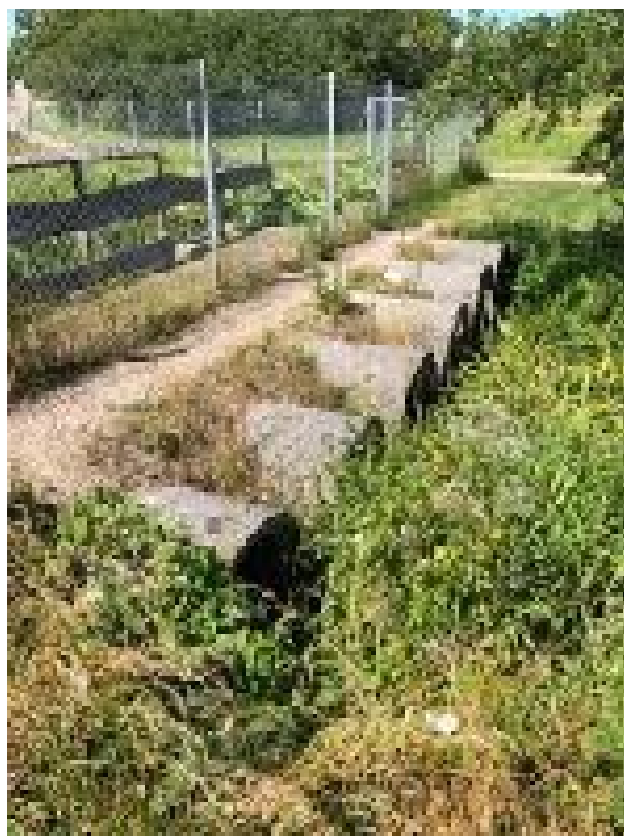
Cementtrummor i bäckfåran är gräns mot bete.
