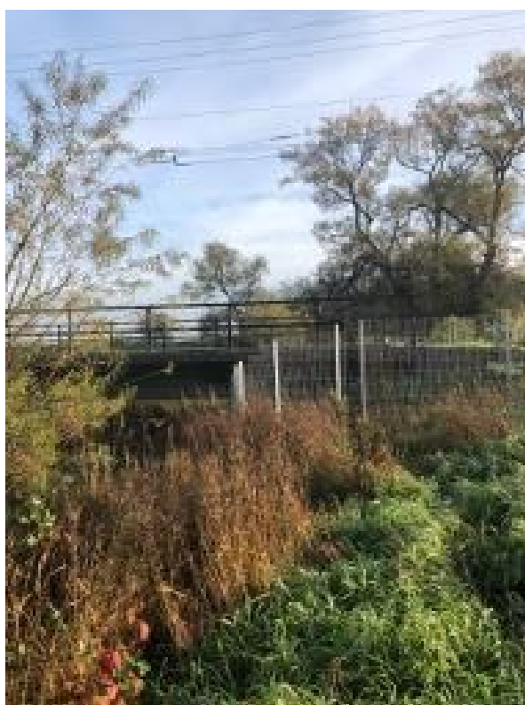
Bro över järnväg
